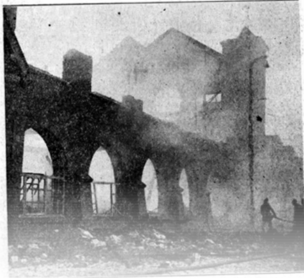
HET GEBOUW VAN DEN HOUTHANDEL „DE RIETVINK” TE EINDHOVEN tijdens den fellen brand, welke daar is uitgebroken. Slechts de zwartgeblakerde muren zijn blijven staan voor zoover zij niet door de brandweer moesten worden ongetrokken, teneinde gevaar voor instorting te voorkomen.
